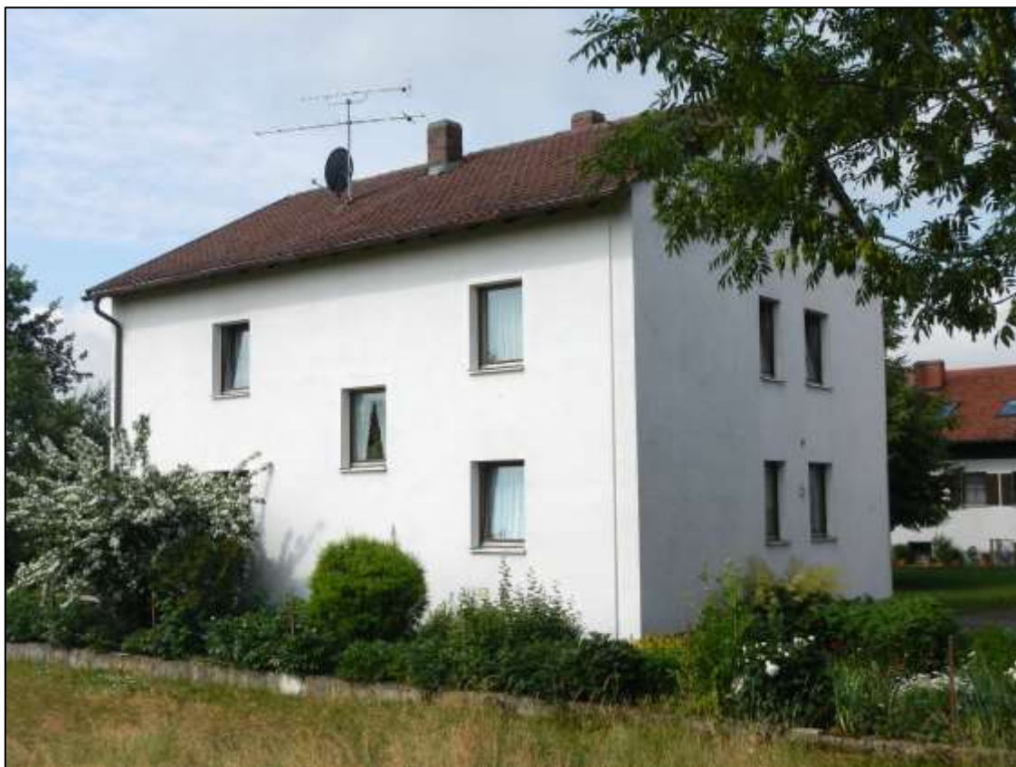
Abbildung 10: Wohnhaus "Landshuter Straße 27 (hier: maßgeblicher Immissionsort IO 2)
